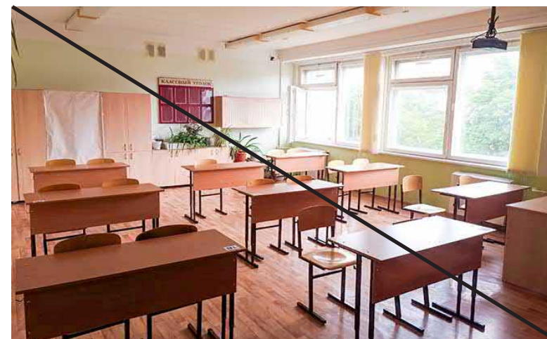
Плохо Линолеум под дерево
