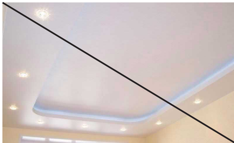
Плохо Многоуровневые гипсокартонные конструкции
